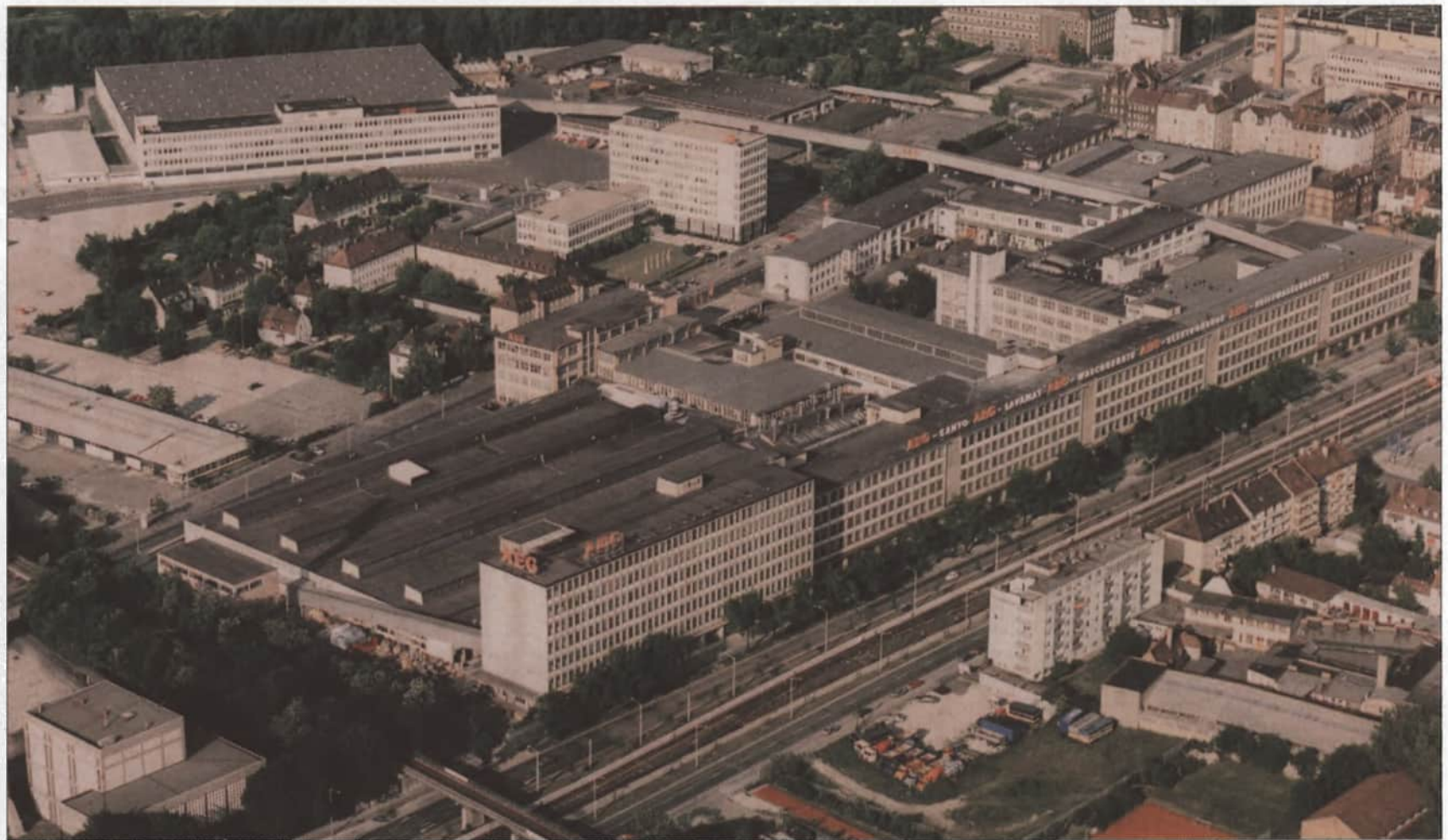
Das riesige Gelände der AEG-Fabrik in Nürnberg vor Jahrzehnten: Noch 1992 gab es große Expansionspläne für den Standort im Stadtteil Muggenhof. Jetzt wird nach einem neuen Investor gesucht. Interessenten für die Immobilie soll es nach Auskunft von Electrolux schon geben. Archivfoto
